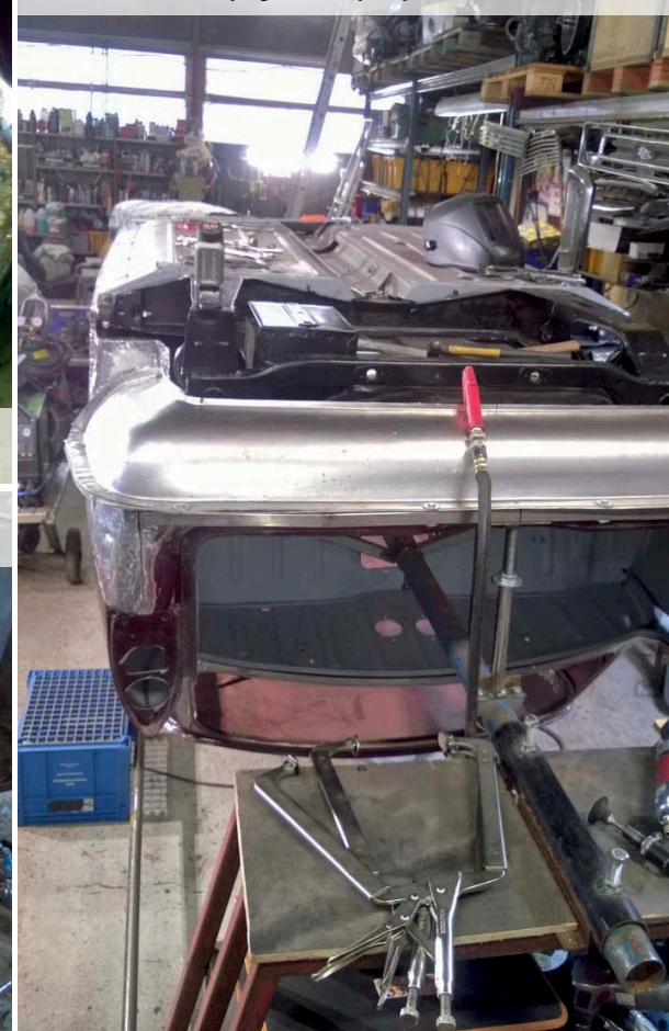
Kaikki uudet lattiat paikoillaan ja hitsiliimalla liimattuna. Kelkatkin kiinni oikeilla paikoillaan tukemassa koko korja . Siispä grilli toisinpäin ja muihin kohteisiin käski.
