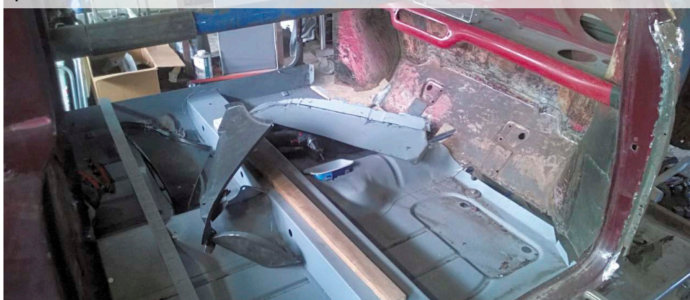
Uuden lattian etureuna ei riitäkään korjaamaan kaikkea ruosteista osuutta rintapellissä, joutuu siis muutamman pellin rakenteleen itse. No sehän on vaan sitä luovaa hommaa se!?
